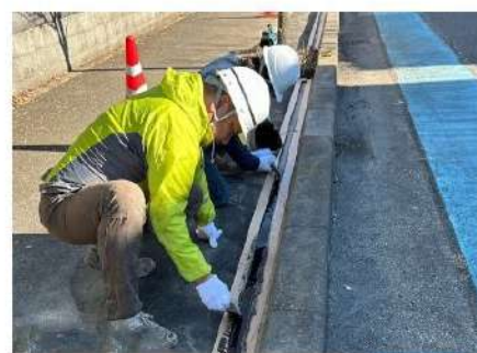
防草カットシール工事
