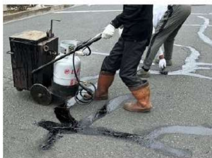
クラック補修工事
