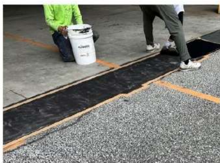
段差修正工事
