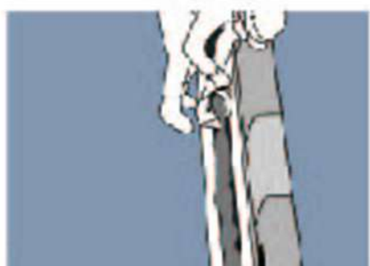
6. 無収縮モルタル充填作業と 敷き均し
